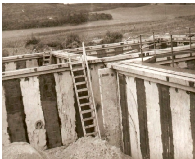
Építés műanyag habarccsal
