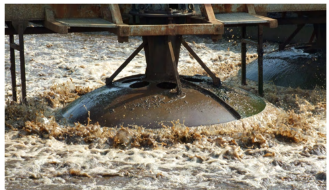
AB-TA aerátor Varimix levegőztető rotor Varimix rotor működés közben
