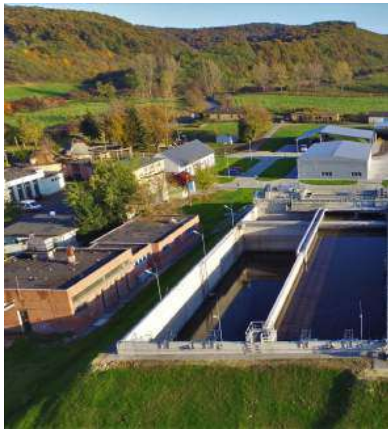
A Cyclator technológiájú ózdi szennyvíztisztító telep
