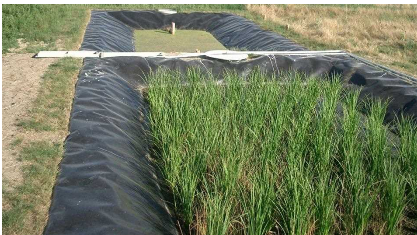
Kombinált gyökérvonalas műtárgy és utótisztító tér
