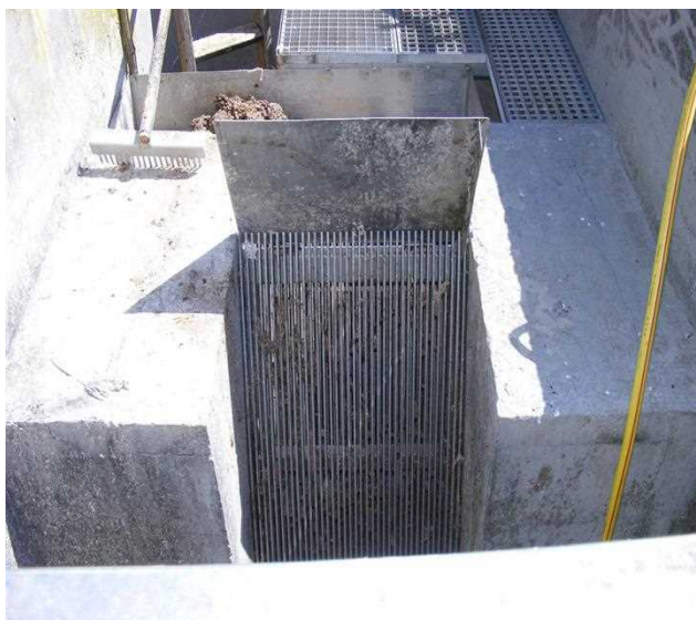
Kézi tisztítású rács
