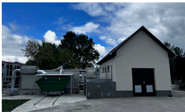
3. kép Az új rács és homokfogó az átépített fúvógépházzal
