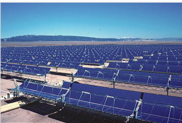
Naphőerőmű Kaliforniában. A tükrök a sugárzást a csövekre irányítják, ahol egy közeg felmelegszik, amivel áramot állítanak elő
