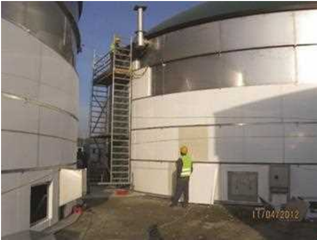
24. ábra. Szigetelés felhordása acél reaktorra
