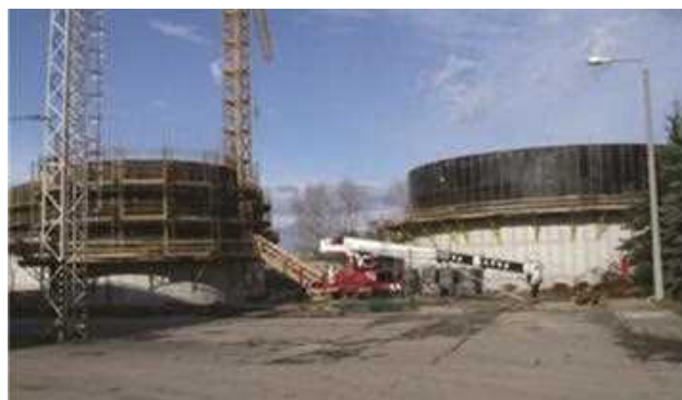
7. ábra. Az É-Bp szvt. kúszó zsaluzással épült rothasztói ( 2 \times 12\,000\text{ m}^3 )
