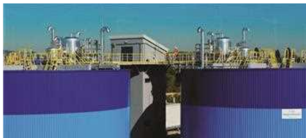
22. ábra. Fűtött anaerob rothasztó kezelőplatója BP-központi telep
