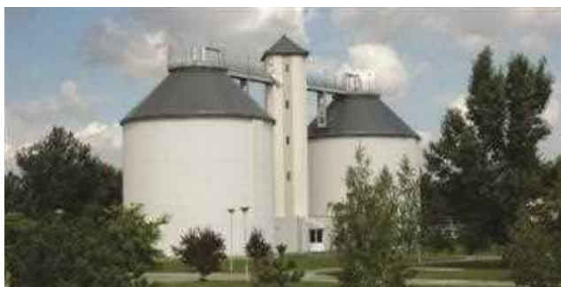
6. ábra. Győri 2 \times 3\,750\text{ m}^3 -es rothasztók
