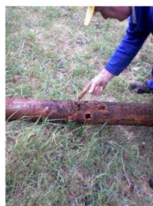
9. kép búvárszivattyú vas-kirakódással
