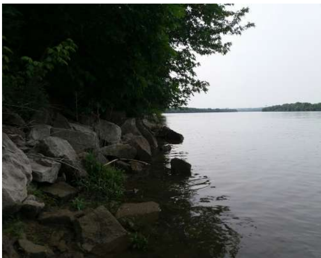
5. kép: A partvédelmi célt szolgáló kockakövek (Baki Zoltán, BÁCSVÍZ Zrt., 2018.)
