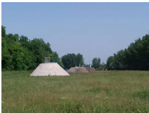
2. kép: A vízbázist termeltető parti szűrésű csőkutak (Baki Zoltán, BÁCSVÍZ Zrt., 2018.)
