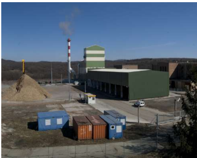
A tűzifával, erdei aprítékkal és egyéb faipari melléktermékekkel fűtött biomassza-kazán 2010-es üzembe helyezése óta biztosítja Komló város távfűtését ( www.komlomedias.hu )
