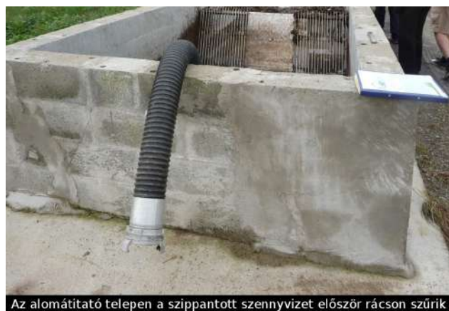
Az alomátító telepen a szippantott szennyvizet először rácson szűrik
