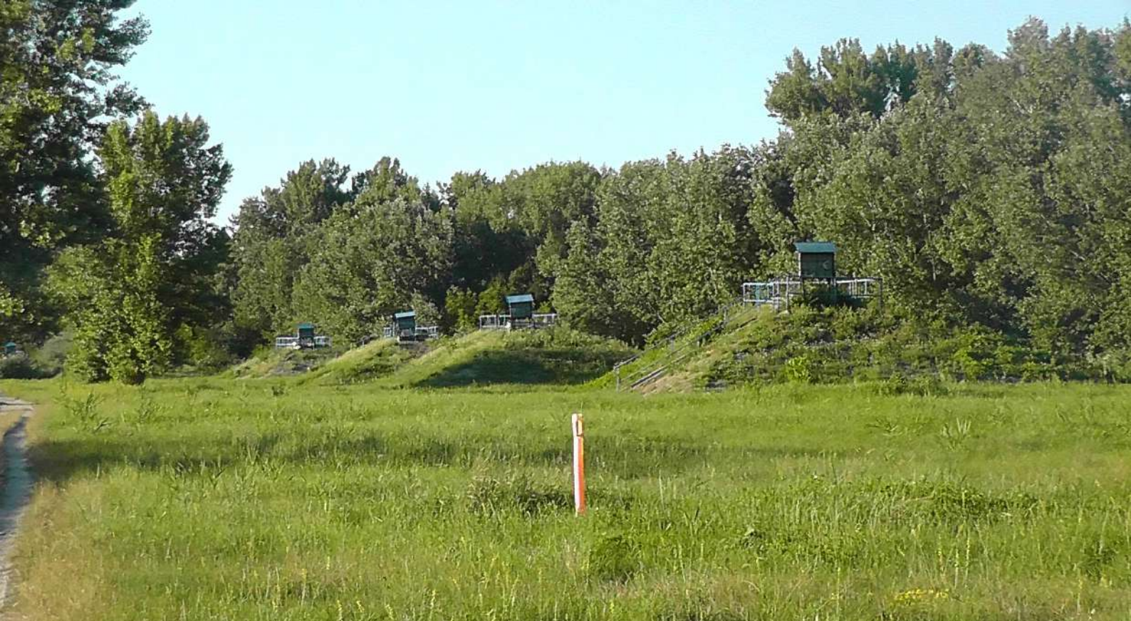
Dunakanyar Tahi vízbázis kútsora. Kapacitás: ~18 000m 3 /d Tervezte: Ráth Imre VÍZITERV (fotó: Szelekovszky Beáta)
