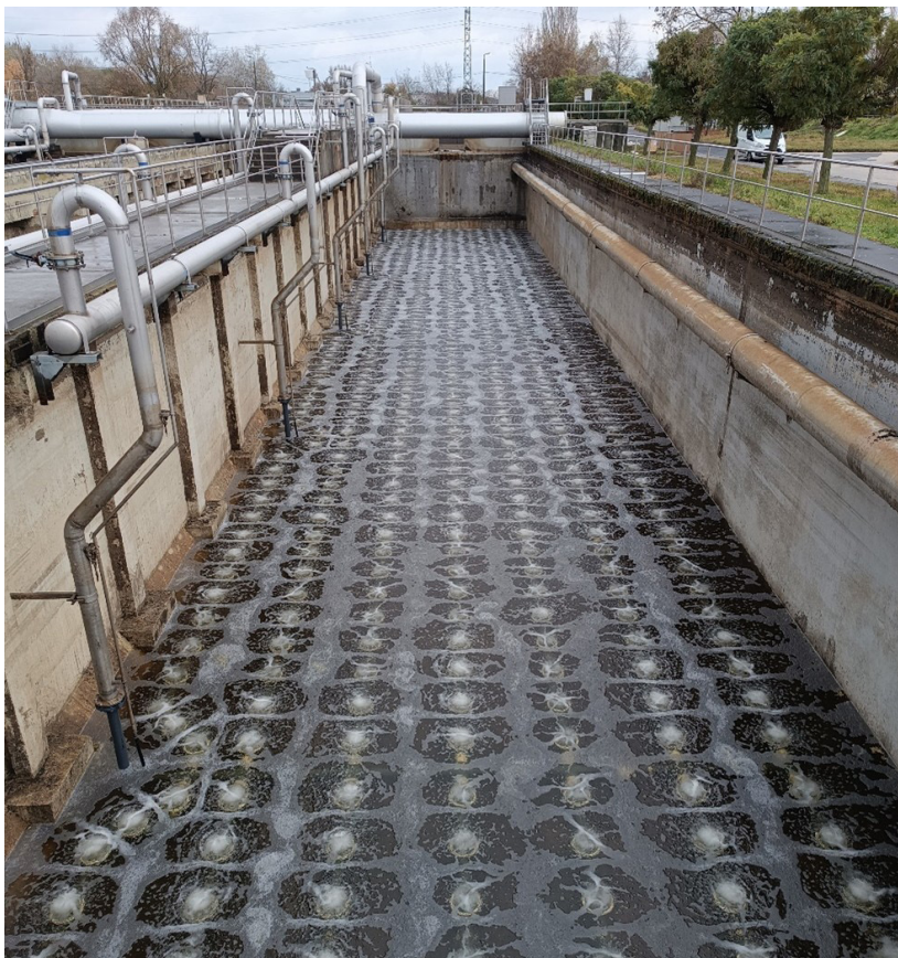
4. ábra -Flygt Sanitaire levegőztető rendszer buborékképe
