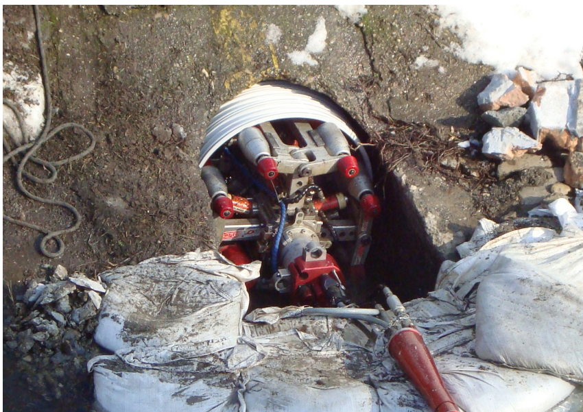
8. sz. fotó Budapest, Ond utca csapadék csatornafelújítás Rotaloc eljárással
