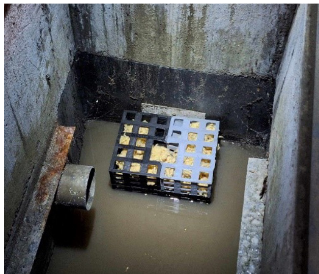
7. ábra A szűrő működés közben
