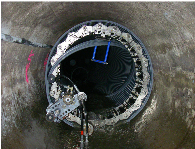
12. sz. fotó Budakeszi úti csatorna felújítása SPR eljárással
