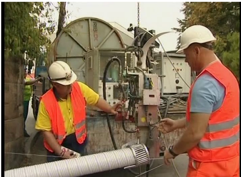
4. sz. fotó Eger, Városház utca csatornafelújítás Expanda eljárással
