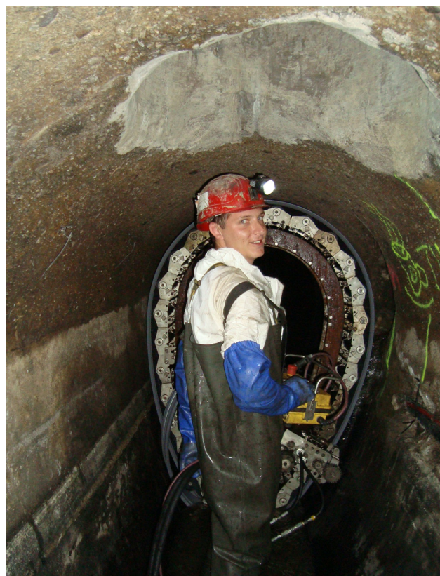
13. sz. fotó Pozsonyi úti csatorna felújítása SPR eljárással
